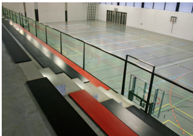
Dispositivo anticaduta di gradinata con vetro stratificato e visuale libera sui campi
