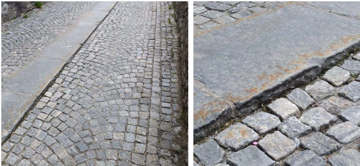
Foto 2 – 3 Cedimento della pavimentazione di Via alla Motta.
