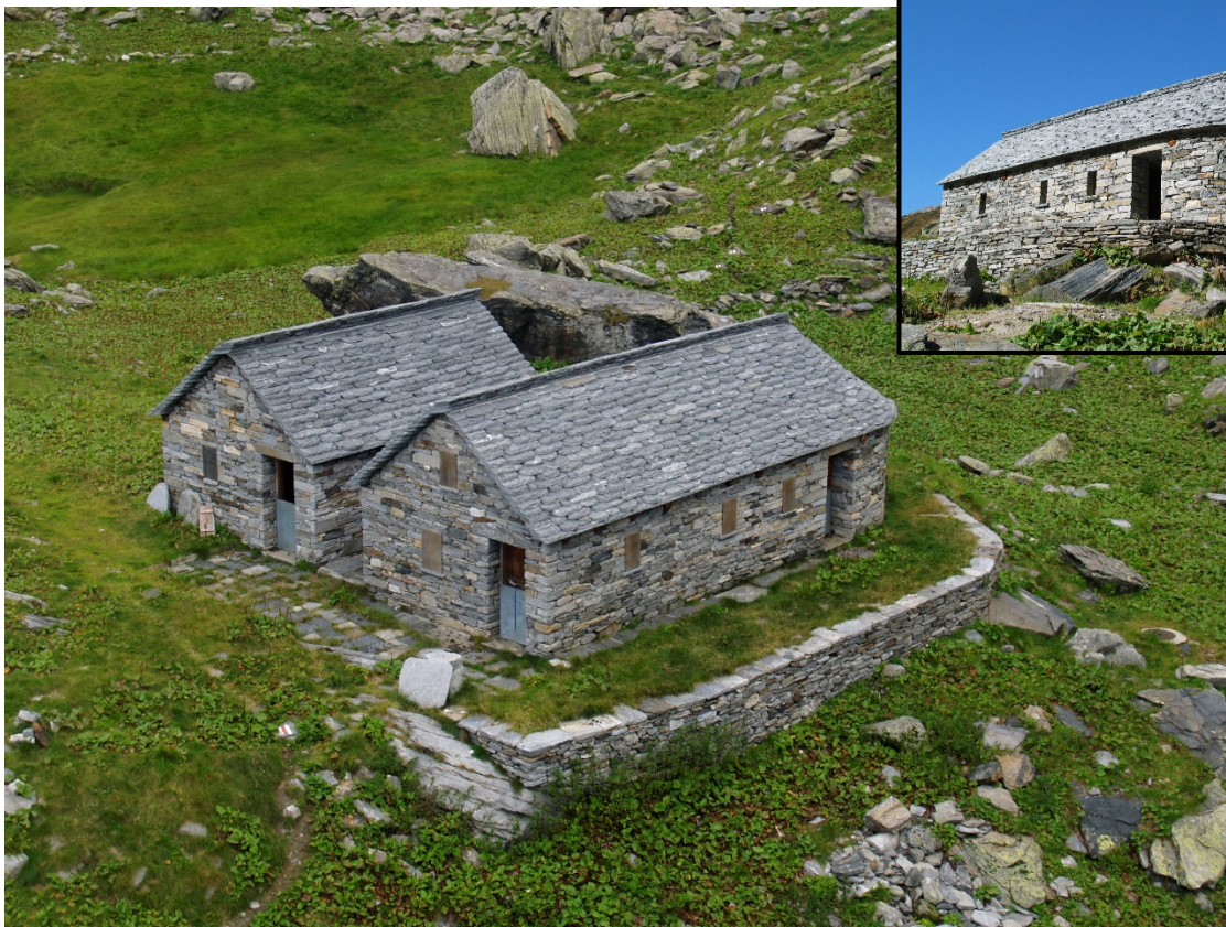
I fabbricati di Lielp
