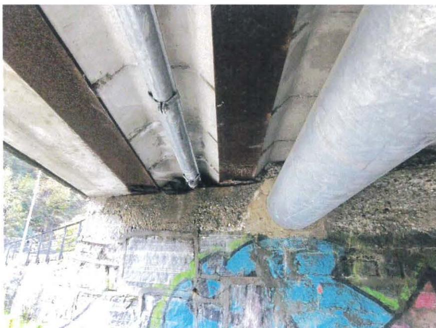
*Foto 4: dettaglio travi corrose spalla destra*
