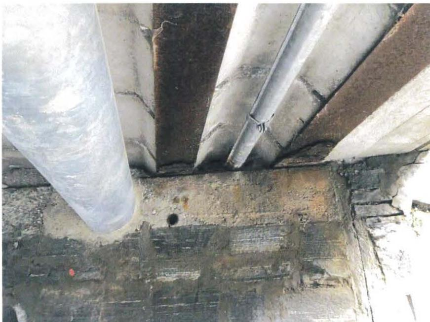
*Foto 3: dettaglio travi corrose spalla sinistra*
