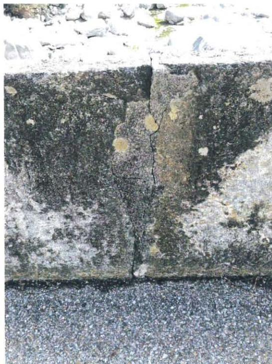
*Foto 6: dettaglio fughe parapetto in pietra*
