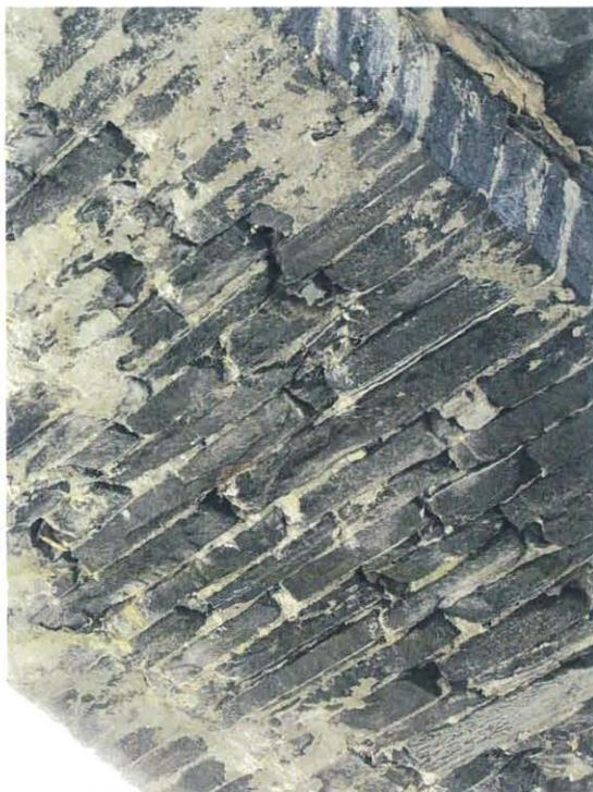
*Foto 5: intradosso volta (fughe deteriorate)*
